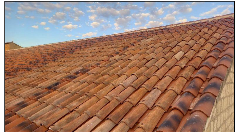
Sichtbar ist bei einem Solarziegel von Dyaqua lediglich die lichtdurchlässige Abdeckung, die wie ein klassischer Terrakottaziegel aussieht.
