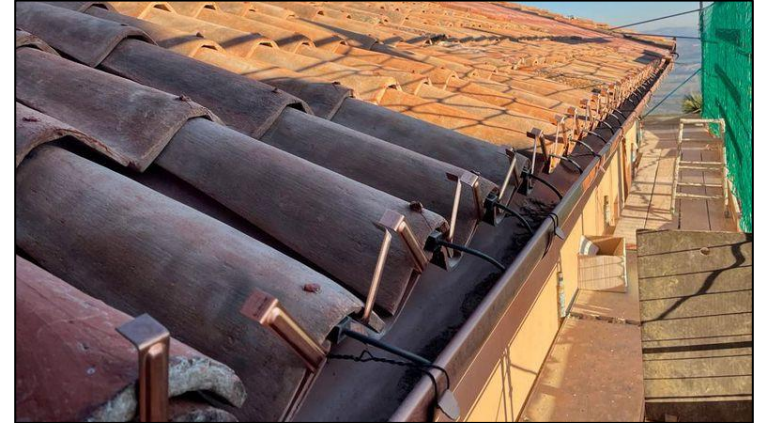
„Invisible Solar Rooftiles“: In den Terrakottaziegeln des italienischen Herstellers Dyaqua stecken Solarzellen.
