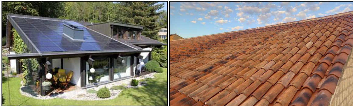
Abbildung 32: Beispiele für innovative Dach-PV-Anlagen; links: Indach-PV-Anlage bei einem Neubau, rechts: originalgetreue PV-Dachschindeln in Terrakottaoptik (ENBW Bande-Württemberg AG, 2024)
