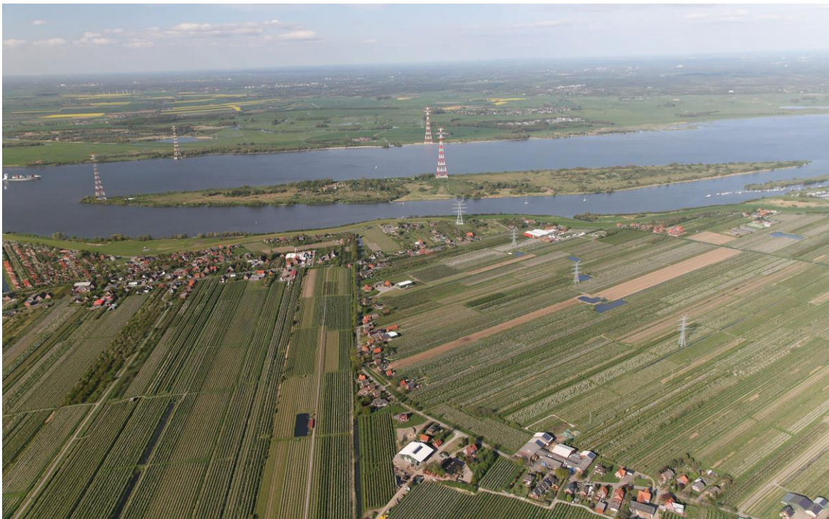
Abbildung 14: Im Hintergrund: Die sogenannte „Elbkreuzung 1“ und „Elbkreuzung 2“, welche als besonders eindruckliche Stromtrassen das Alte Land mit Schleswig-Holstein jenseits der Elbe verbinden, im Vordergrund: kleinere Stromtrassen im Gebiet der Samtgemeinde Lühe (Wikimedia, 2012)
